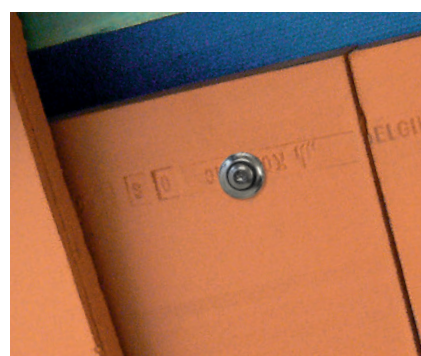
Vis Torx en inox avec anneau EPDM 4,5x35 mm pour les tuiles plates
