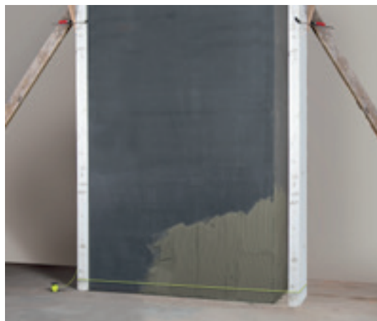
Des profilés de mesure correctement installés faciliteront la mise en œuvre des plaquettes.
