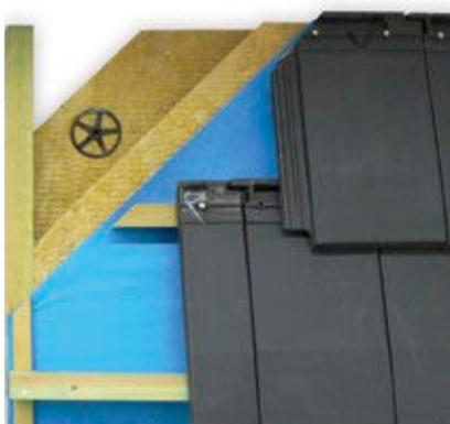
Structure porteuse en cas d'isolant souple
