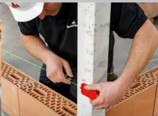
9. Appliquez le cordeau de maçon à une hauteur de \pm 2 cm sous la hauteur de la seconde couche
