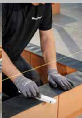
11. Placez la membrane d'étanchéité et compressez celle-ci correctement sur la mousse Dryfix extra appliquée
