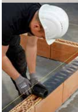
11. Placez la membrane d'étanchéité et compressez celle-ci correctement sur la mousse Dryfix extra appliquée
