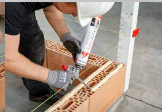
10. Appliquez Dryfix extra en 2 cordons de 3 cm de largeur, à \pm 1 cm des côtés extérieurs du bloc
