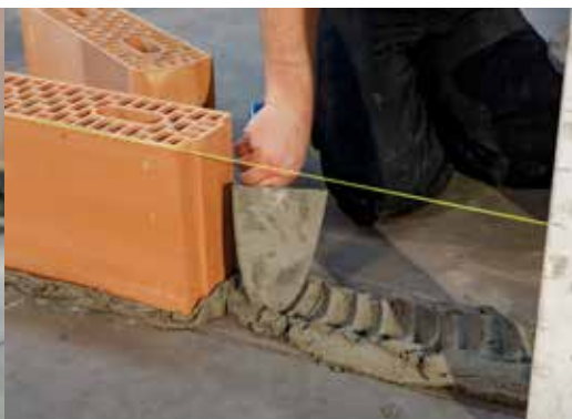
4. Maçonnez la première couche (couche d'assise)
