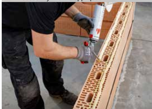
16. Appliquez Dryfix extra en 2 cordons de 3 cm de largeur, à \pm 1 cm des côtés extérieurs du bloc
