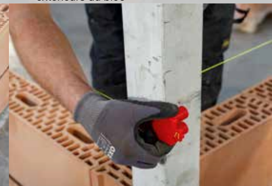
15. Appliquez le cordeau de maçon à une hauteur de \pm 2 cm sous la hauteur de la couche suivante
