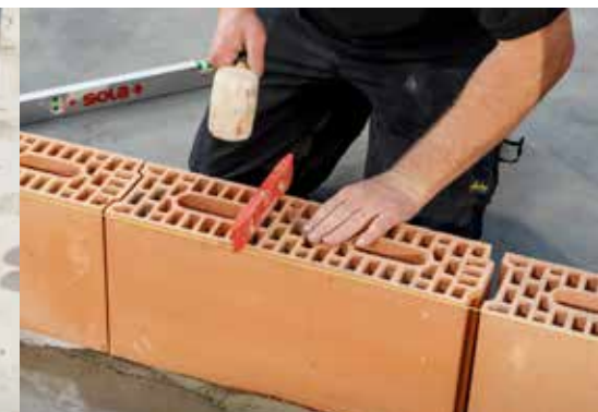
5. Contrôlez la planéité perpendiculairement au mur
