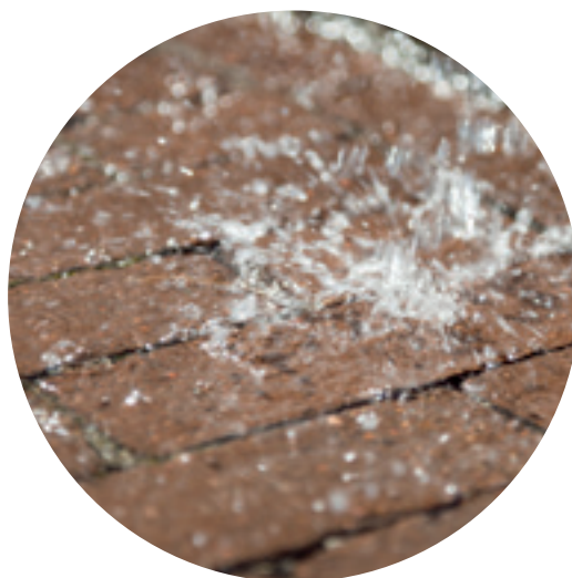
Des pavés en terre cuite drainants ont été appliqués au Quartier Durable. Il s'agissait des prédécesseurs des pavés actuels Passaqua.
