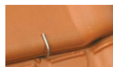
F support de latte faîtière ajustable
