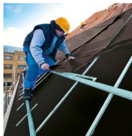
Les tuiles de récupération laissent généralement filtrer beaucoup de lumière à hauteur du recouvrement. Grâce à sa haute stabilité aux UV, Fleece Maxi constitue l'écran de sous-toiture idéal pour remédier à ce problème.
