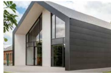
Pose horizontale à recouvrement double
