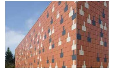
Pose inclinée à recouvrement double
