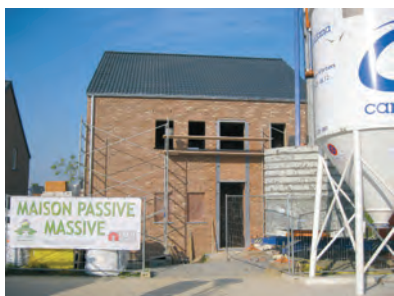
Préparation des coffrages
