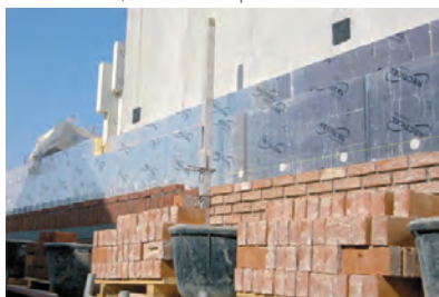
Chape isolante 30/40 cm polyuréthane
