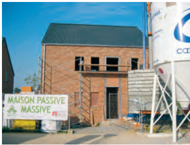
Vorbereiding van de bekistingen
