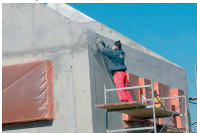
PUR-isolatie minimum 20 cm
