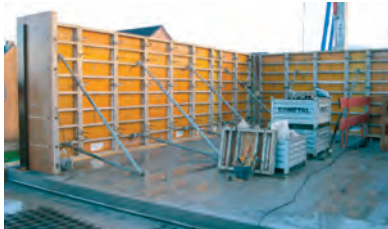
Afwerking van het beton : precisiewerk
