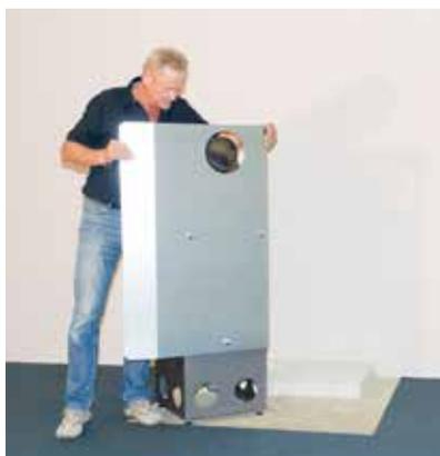
Monter la tôle de protection thermique (accessoire)
