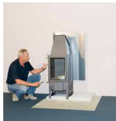
Orienter l'insert de cheminée à l'aide du niveau à bulle
