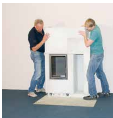
Assembler les éléments d'habillage un à un et les coller
