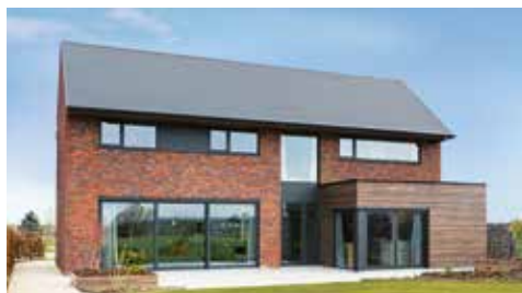
Maison témoin 5081 Saint-Denis-Bovesse (Rue du Noly 47)
