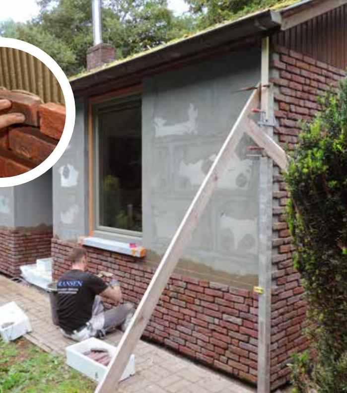
>Structure Façabrick réalisée avec des plaquettes Terca Artiza Bleu Mauve Escarbille
