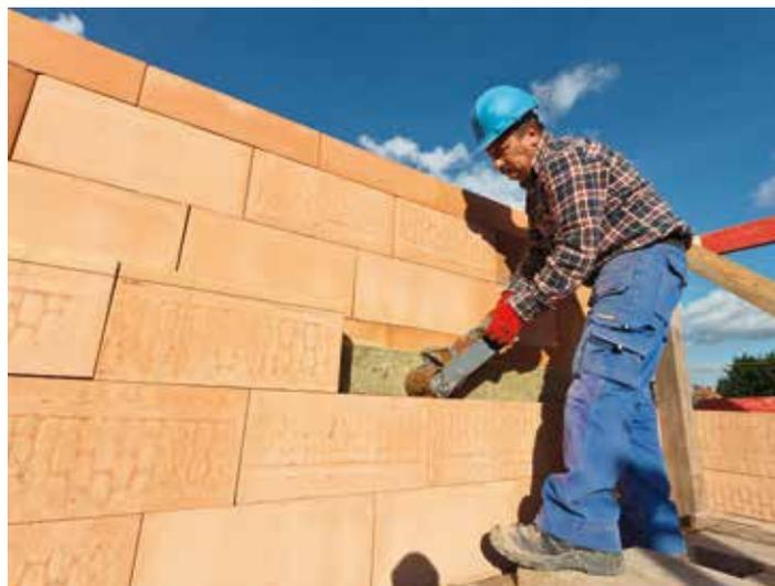
Cette propriété empêche un échauffement ou refroidissement trop rapide à l'intérieur de la maison. Le parachèvement avec une couche d'enduit du côté intérieur des blocs pour murs intérieurs garantira l'étanchéité à l'air du mur. Les blocs pour murs intérieurs peuvent faire valoir d'excellents résultats au niveau acoustique. Ce qui s'avère très intéressant pour les maisons mitoyennes ou semi-mitoyennes, ou pour les maisons dans des rues fort fréquentées.
