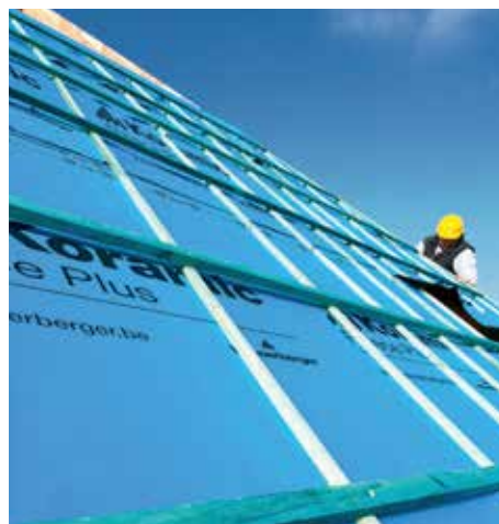
Grâce à son revêtement spécial, Fleece Plus résiste mieux aux fluctuations de température et aux rayons UV que les écrans de sous-toiture traditionnels. En outre, cet écran bénéficie d'une action capillaire.
