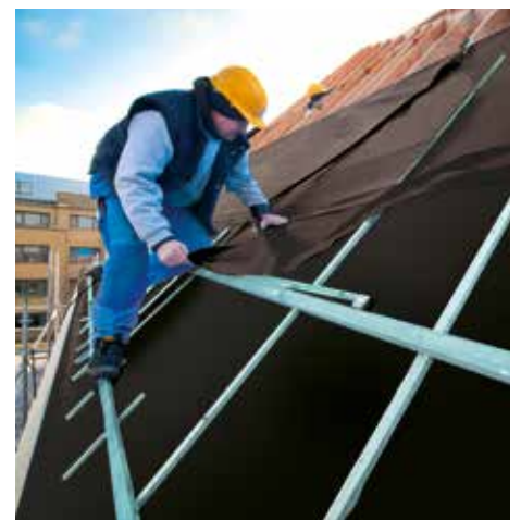
Les tuiles de récupération laissent généralement filtrer beaucoup de lumière à hauteur du recouvrement. Grâce à sa haute stabilité aux UV, Fleece Maxi constitue l'écran de sous-toiture idéal pour remédier à ce problème.
