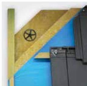
Structure portante en cas d'isolant souple
