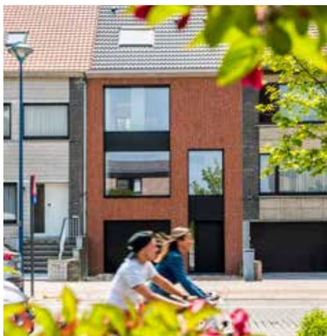
*“ Ici a été appliqué le système de façade Façabrick, une solution par laquelle des plaquettes sont collées sur l'isolation sans ancrages structurels supplémentaires.”*
