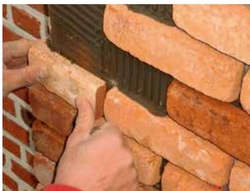
Les plaquettes forment la solution idéale pour les endroits où vous ne disposerez pas de la largeur normale d'une brique de parement traditionnelle.
