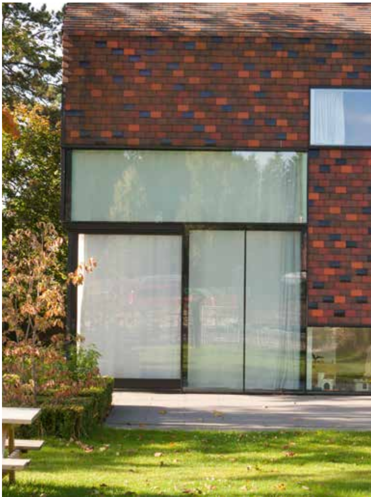
Tuile Plate 301 - Mélange de 10% Rouge naturel, 30% d'Amarante, 50% de Rustique et 10% d'Anthracite Vanden Eeckhoudt – Creyf Architectes, Bruxelles/Brussel
