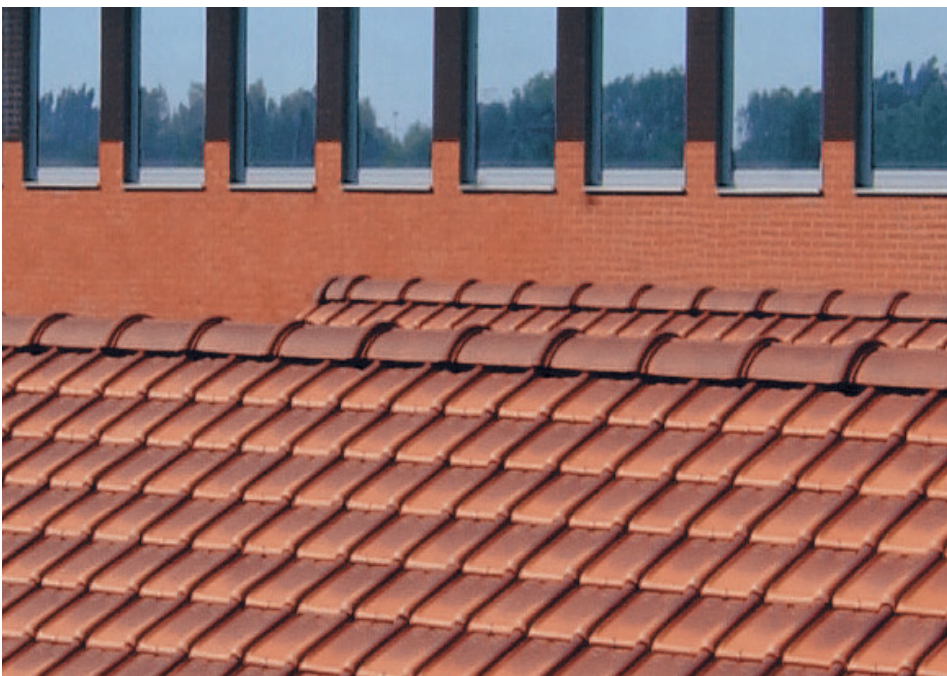
Utilisation de sous-faîtières de ventilation sous des faîtières à emboîtement
