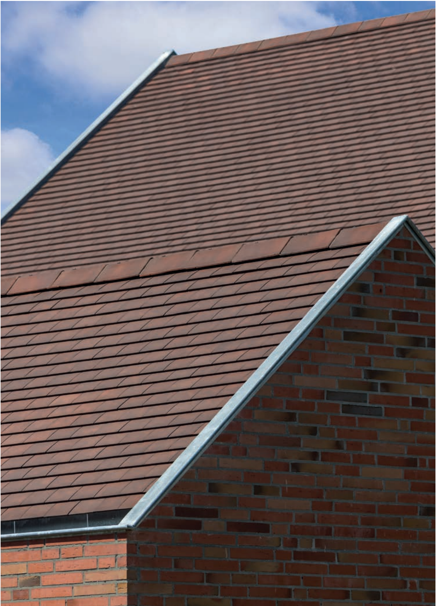
Tuile Plate 301 Rustique: Alu-Rol Extreme 210 mm - sous-faîtière de ventilation sous des faîtières angulaires à emboîtement
