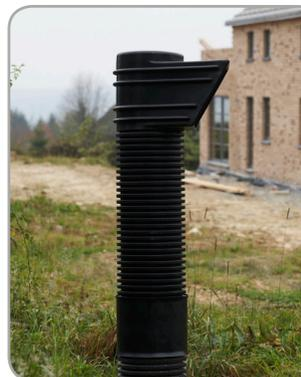
L'évacuation de l'air chargé de radon doit se faire à bonne distance du bâtiment, ou au niveau du toit, pour éviter que le radon rentre dans le bâtiment
